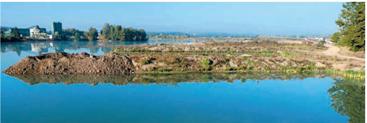
Blick von Osten auf die neu angelegten Landzungen: im Hintergrund vor dem Kiestransportschiff der „West-Finger“ bereits auf Verlandungswasserspiegel abgeflacht; davor rechts mit grünem Binsen-Gürtel und im Vordergrund frisch aufgeschüttet zwei weitere „Finger“; im Hintergrund das Firmengelände der Firma Jäggle (Oktober 2018).
