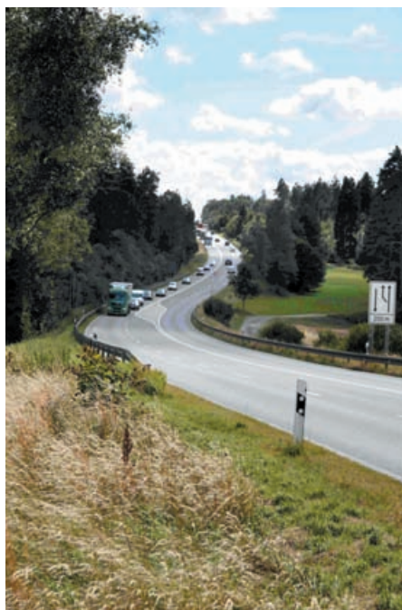
Die B 31 nach dreispurigem Ausbau (2004 / 05).
