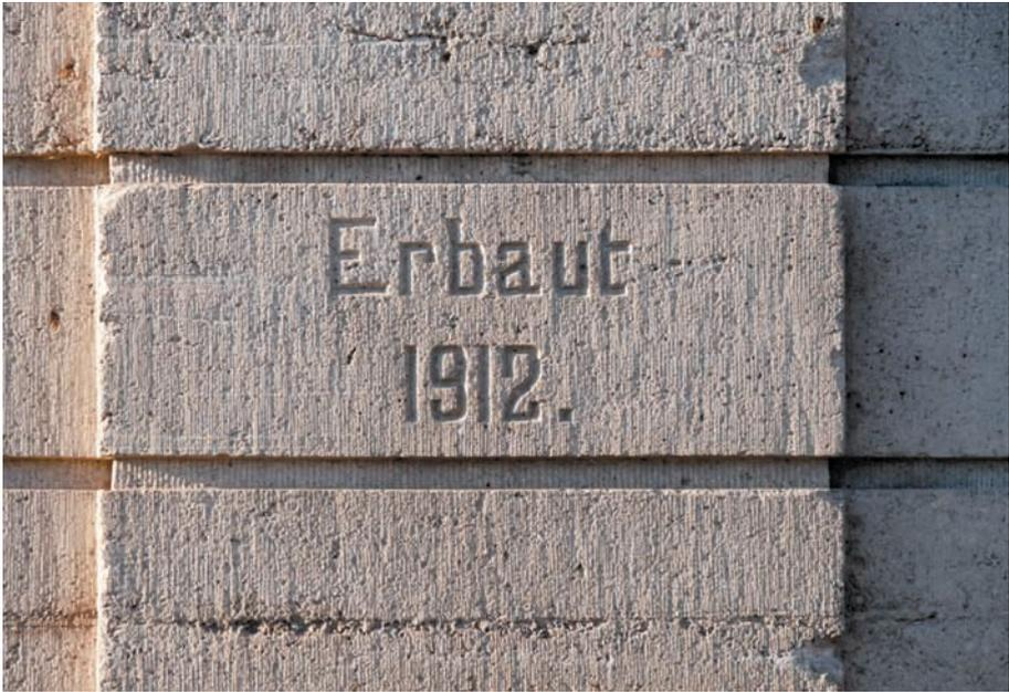
Oberflächenstruktur der Pilaster. Die händische Nacharbeitung des Steinmehlvorgusses mit dem Scharrieseisen und die nachträglich eingeschlagene Jahreszahl sind gut zu erkennen.
