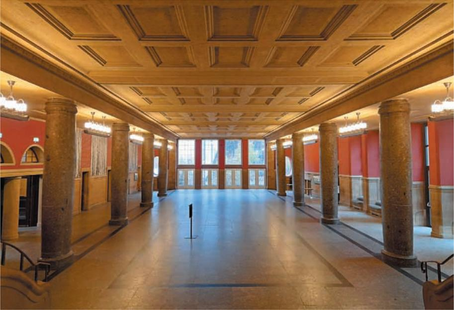
Vorbild für die Statik der Brücke: Die von Brenzinger erstellte Decke über der Eingangshalle des heutigen Kollegiengebäudes I der Universität Freiburg. Die hohe Spannweite des Mittelschiffs wird durch Eisenträger ermöglicht, die mit Gegengewichten über den Seitenschiffen belastet sind.
