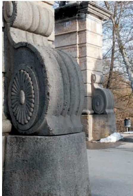
Die Prellsteine an den Pilastern. Steinmehlvorguss, anschließend von Hand überarbeitet.
