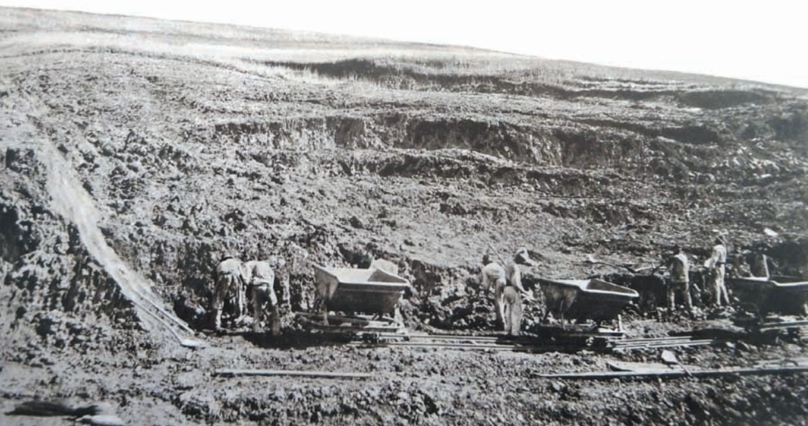
Die durchnässten und steilen Böschungen stürzten immer wieder ein. 2 Archiv Reimer.
