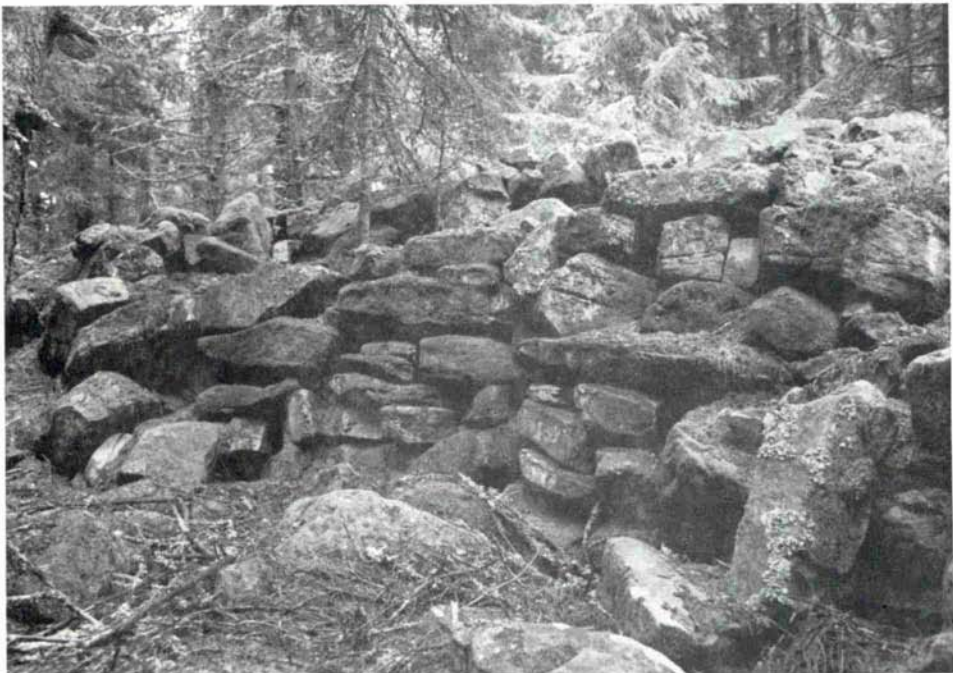
Abb. 7 Trockenmauer(n) im Wallbereich (Foto: Maya)
