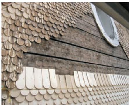
Im Jahr 2005 wurden die schadhaften Bereiche der vielen hundert kleinformigen, halbrund geformten und deckend gefärbten Holzschindeln durch einen erfahrenen Handwerker aus Einsiedeln in der Schweiz und mit der Unterstützung des Hausherrn saniert.
