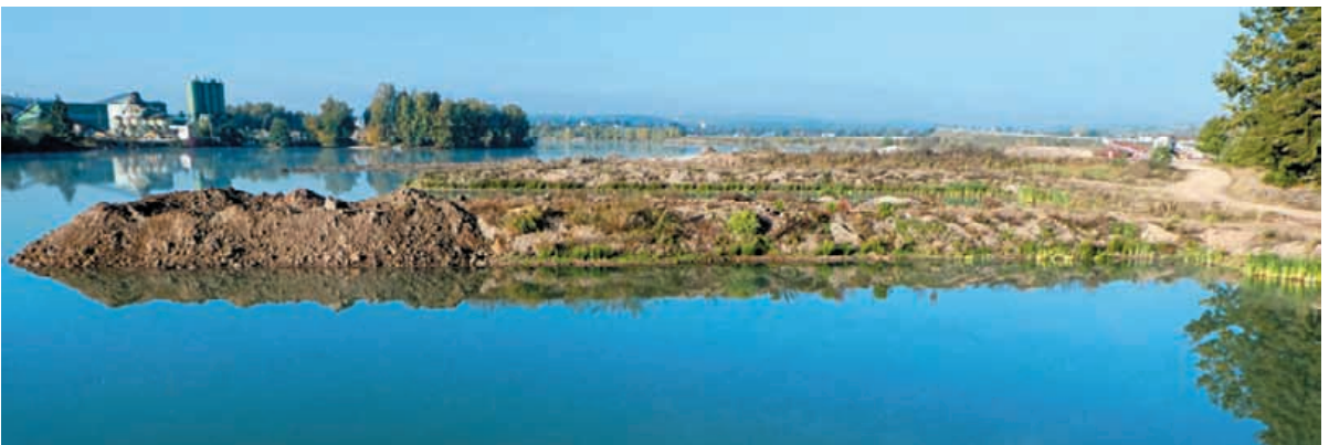
Blick von Osten auf die neu angelegten Landzungen: im Hintergrund vor dem Kiestransportschiff der „West-Finger“ bereits auf Verlandungswasserspiegel abgeflacht; davor rechts mit grünem Binsen-Gürtel und im Vordergrund frisch aufgeschüttet zwei weitere „Finger“; im Hintergrund das Firmengelände der Firma Jäggle (Oktober 2018).
