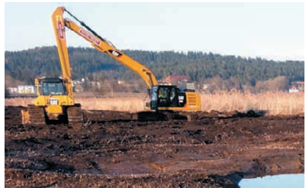
Langarmbagger und Spezialraupe im Einsatz.
