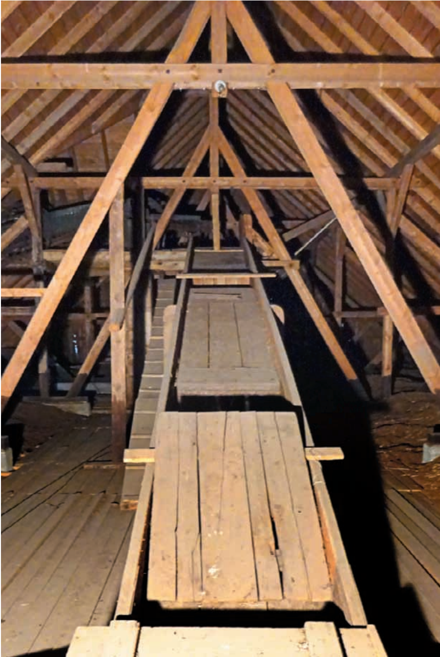
Die Eisplatten wurden auf Holzrinnen zur Verteilung und zum Abgleiten in die Eisregale und Lagerbuchten rangiert. Foto: Hubert Mauz
