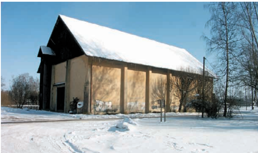
Das Eishaus von Süden mit Treppenhausembau und Tor. Foto: Hubert Mauz.
