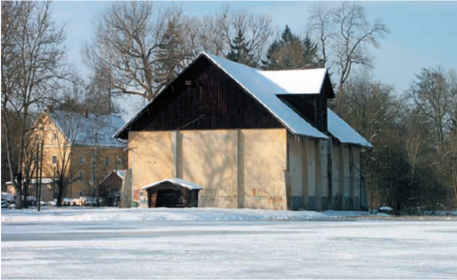
Eishausansicht von Nord-Ost von der zugefrorenen Eiswiese aus. Rechts die Wiederkehr, in der der schräg angelehnte Elevator endete. Foto: Hubert Mauz
