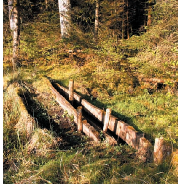
Beispiel einer Entwässerungssperre im Fördergebiet Plattenmoos.
